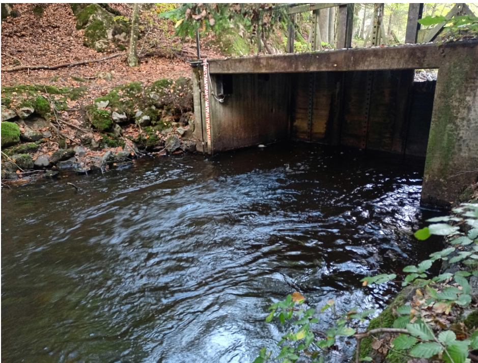
Bild på reglerluckorna vid Hängbrunnen utlopp (foto: Naturfokus).
