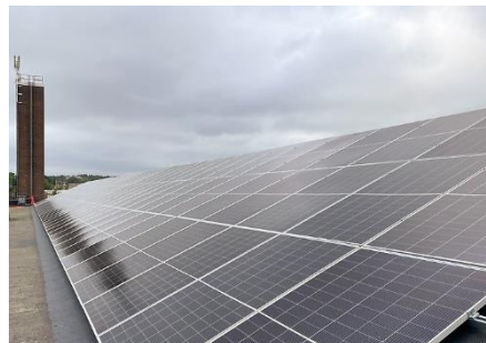
Figur 2 Solceller som ABRI har installerat på Telefonens tak.
