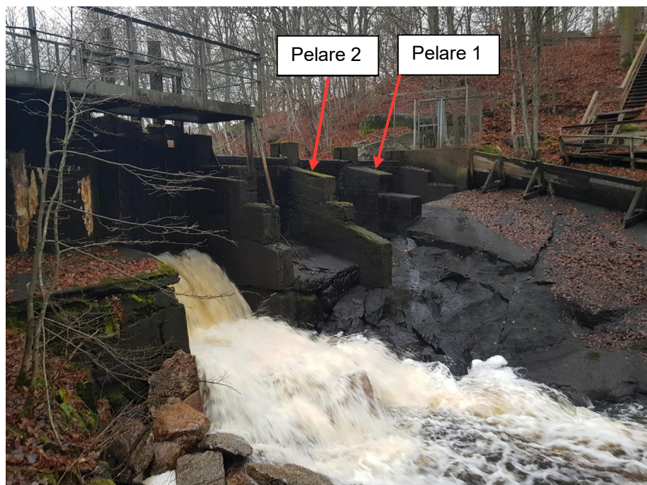
Figur 1. Nedströms foto där pelare 1 och pelare 2 syns. Vatten flödar genom flodutskov.
