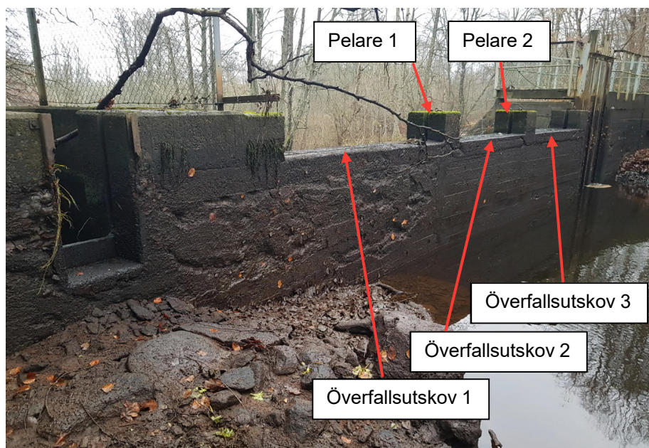
Figur 2. Uppströms foto där pelare 1, pelare 2 och överfallsutskoven syns.
