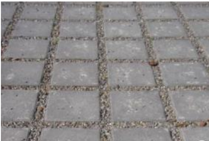
Figur 23. Exempel på genomsläpplig betongbeläggning med grusfogar.
