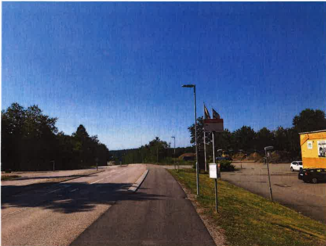
Figur 8. Västervägen i Djupafors med Vänstersvängskörfält, busshållplats och gång- och cykelbana med GCM-stöd. Vy från norr.
