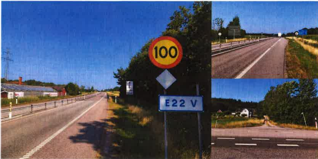
Figur 10. Väg 27 med breddad vägren och anslutning till enskild väg.
