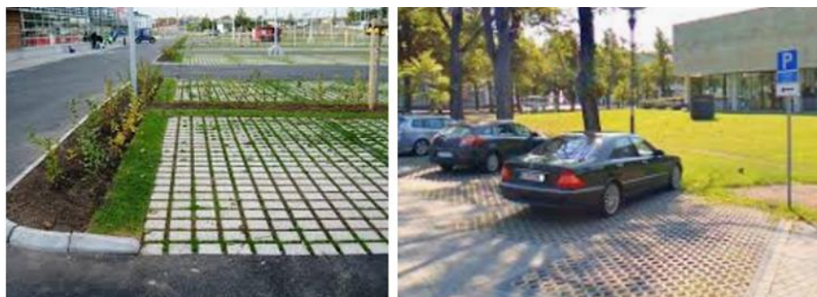
Figur 15: Exempel på parkeringsplatser, Sweco 2019.
