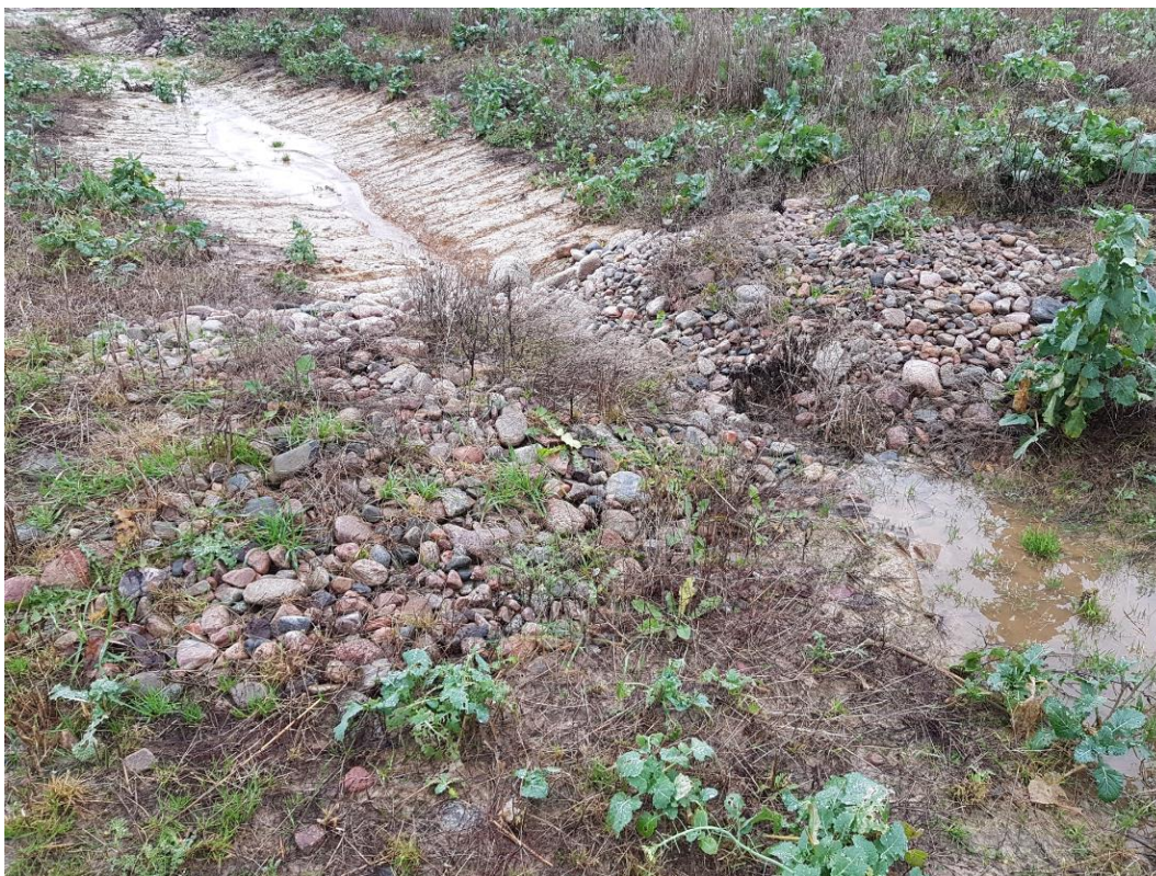
Figur 5: Naturlig avrinning i dagsläget via diket öster om planområdet. Foto: fältbesök, Sweco 2019.
