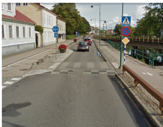
Chikan som smalnar av körbanan gör att trafiken rör sig i en lägre hastighet och med jämna motorvarv vilket minimerar motortrafikbuller.
