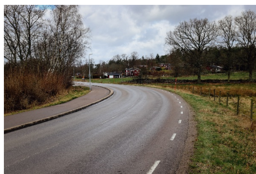
Figur 31 Sikt mot Rustorpsvägen i norr.
