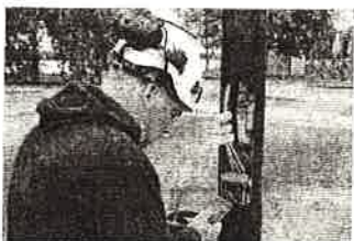
Andreas Andersson installerar laddteknik i lyktstolpen.
