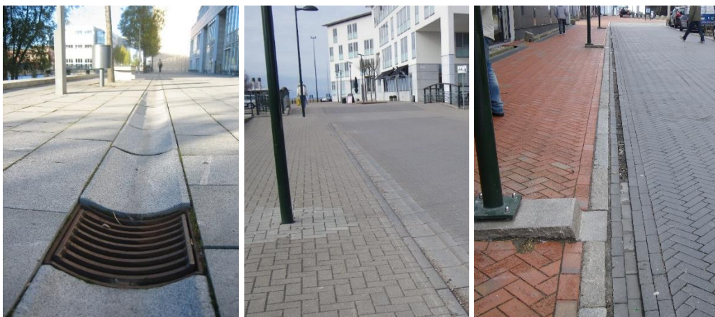
Figur 9: Exempel på öppna dagvattenrännor (Sweco, 2019).
