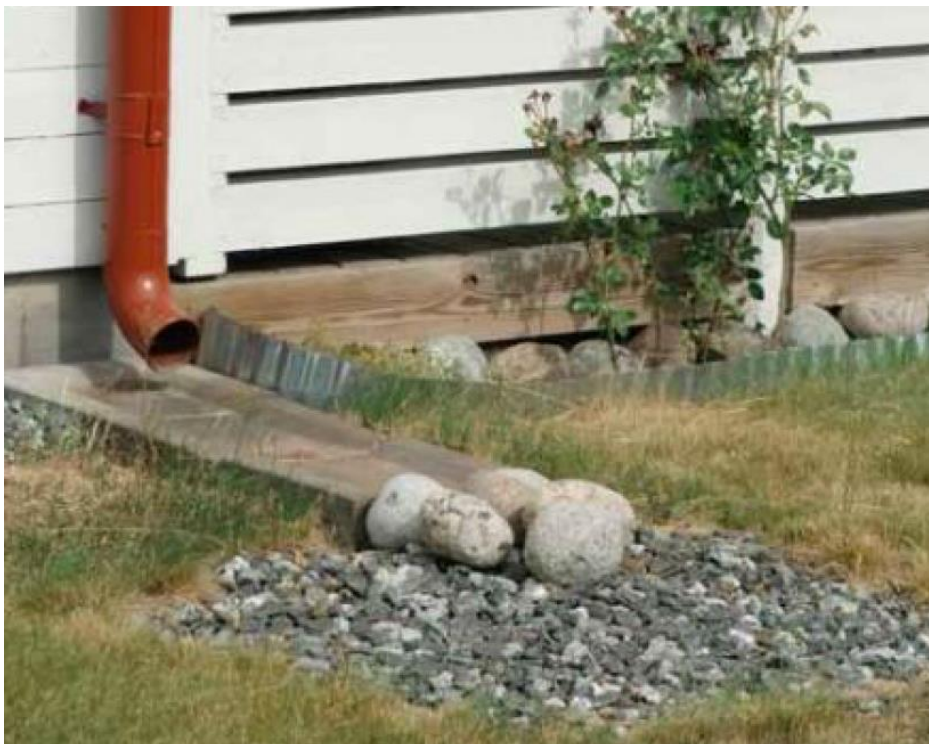
Figur 8: Stuprörutkastare med rännalsplattor med erosionsskydd som leder ut vattnet på gräsmatta. Foto: Dagvattenhandbok Haninge kommun 2019.
