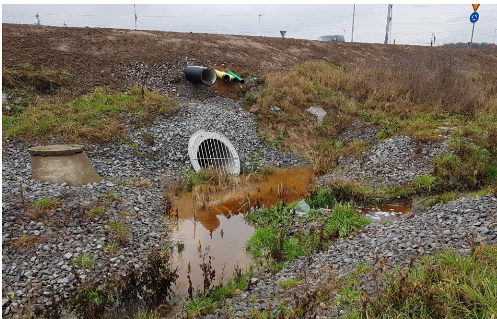
Figur 13: Anslutningspunkt till den befintliga dammen. Foto: fältbesök, Sweco 2019.
