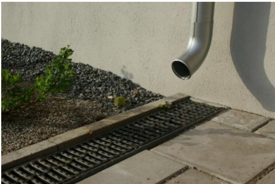
Figur 7: Dagvattenränna (Sweco, 2019).
