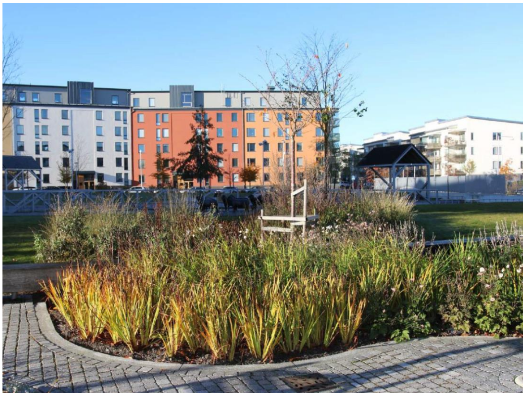
Figur 17. Exempel på nedsänkt växtbädd (Solna stad dagvattenstrategi, 2018).
