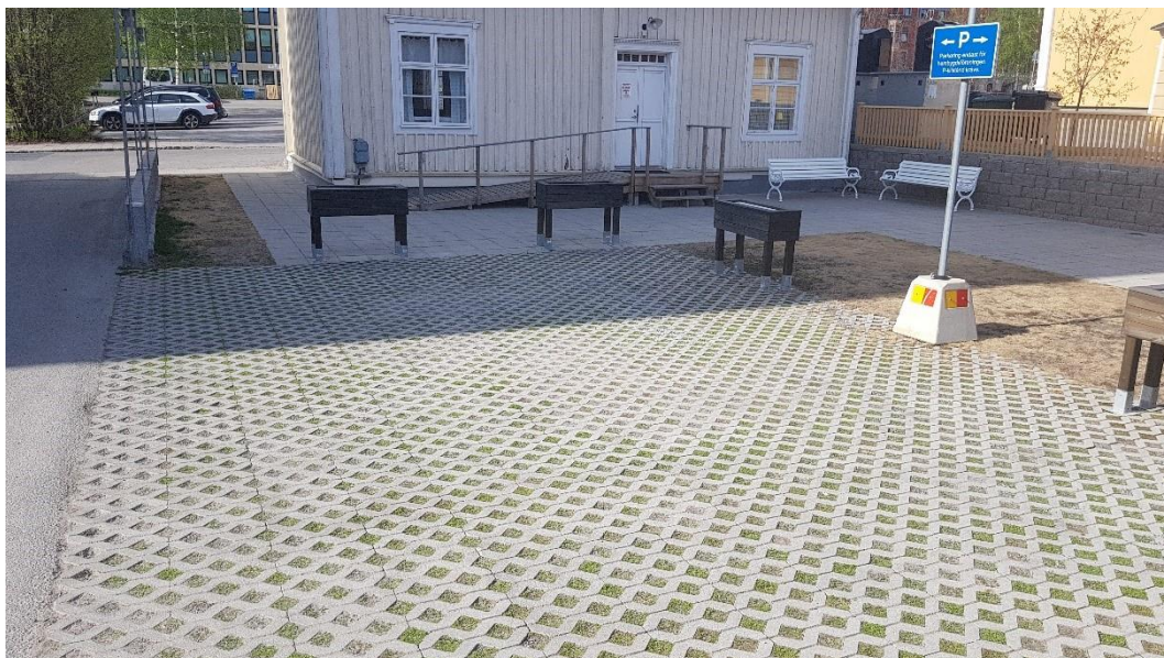
Figur 25. Genomsläpplig beläggning i form av gräsarmerad betong på parkering i Luleå. Foto: AFRY.
