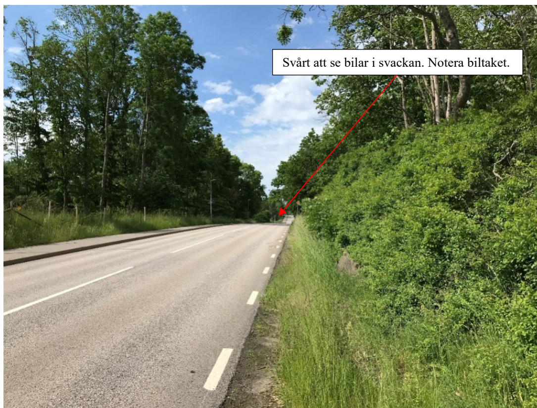
Bild 2 - Risatorpsvägen, vy mot norr. Notera den dåliga sikten i svackan. Bilden är tagen i en nivå på ca 1.5–1.6 m över marken och taket på bilen i svackan är knappt synligt.
