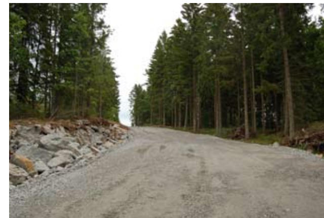
Område 7 i höjd med Kroksjön, förberedelse av transportväg för vindkraftverk.
