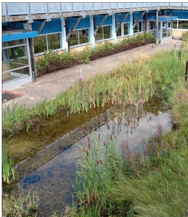
Damm för att fånga upp dagvatten. Dagvattendammar kan utformas på olika sätt och bilda estetiska element med en mångfald av funktioner i en stadsmiljö. Augustenborg, Malmö.
