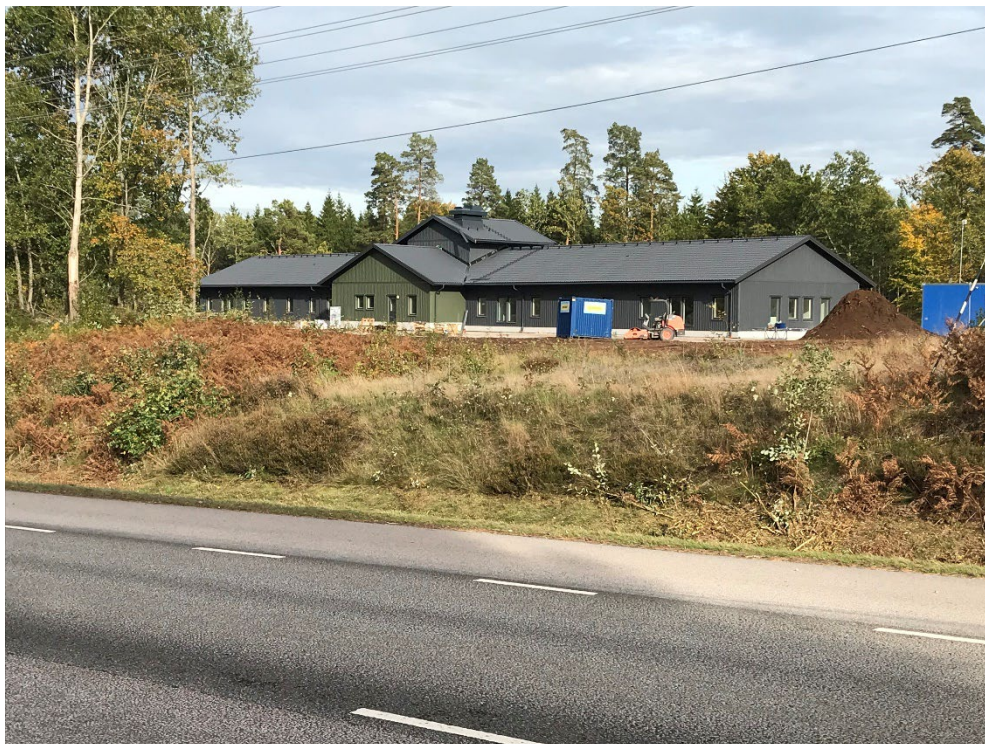
Fotografi av förskolans nybyggnation på Kalleberga 8:269 sett från Ronnebyvägen.
