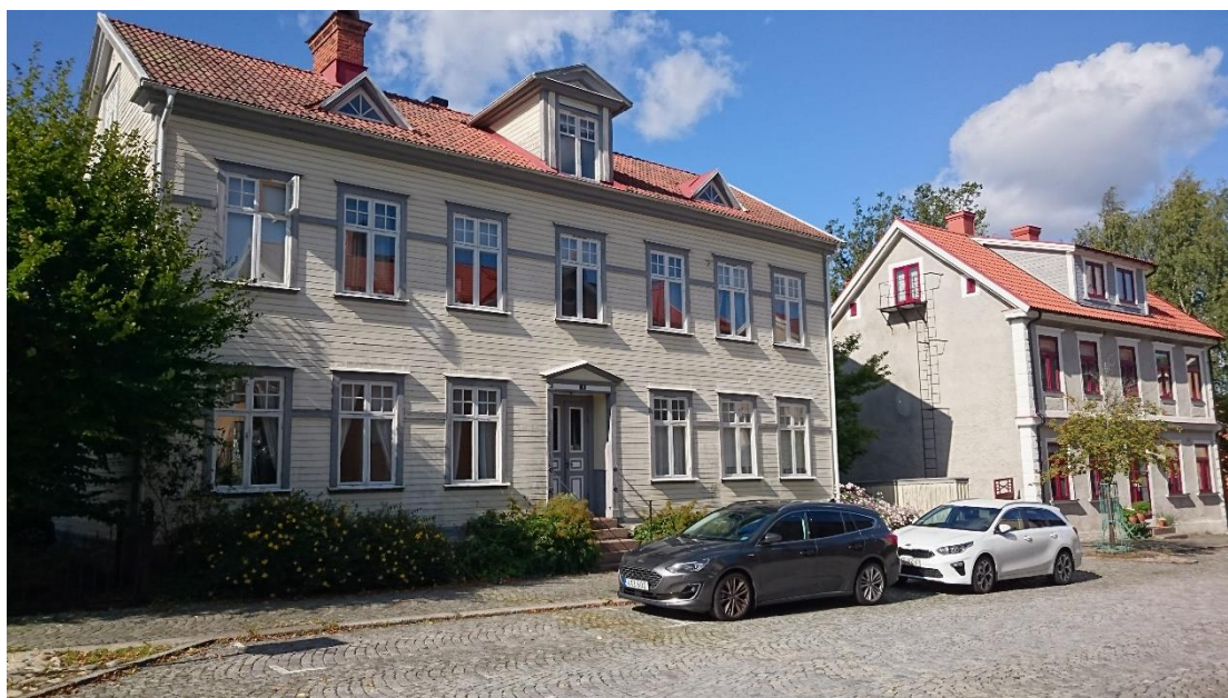
Huvudbyggnaderna på fastigheterna Gertrud 22 och 25 uppvisar höga kulturvärden och tillhör den bebyggelse som uppfördes då kvarteret anlades.
