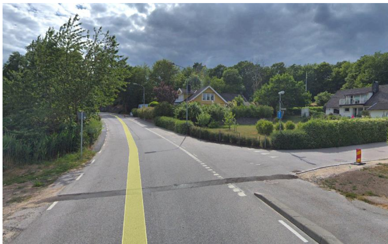
Foto mot väster längs Risanäsvägen där gång- och cykelbanan övergår från kantsten till målad linje.
