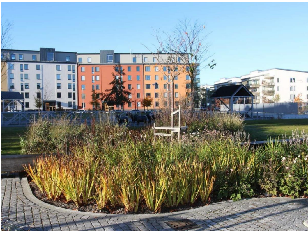
Figur 23. Exempel på nedsänkt växtbädd (Solna stad dagvattenstrategi, 2018).
