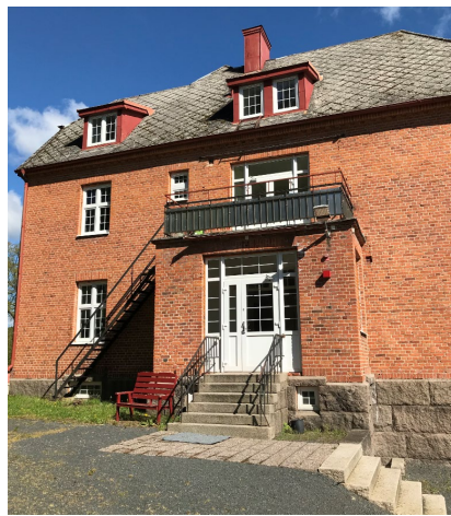
Befintlig balkong i söder
