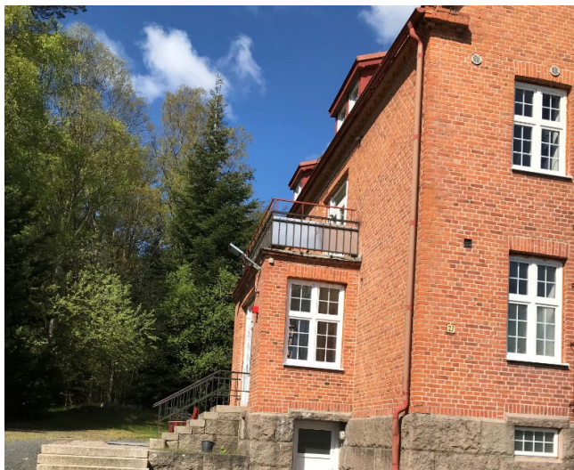
Befintlig balkong i söder
