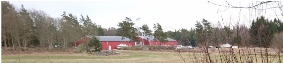
Befintlig byggnad öster om planområdet.
