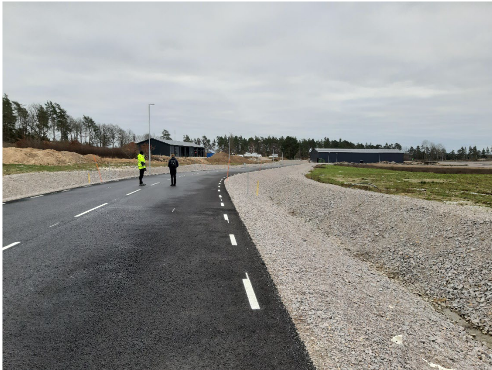
Fotografi från planområdets norra del i riktning mot söder där bebyggelsen inom Frakten 1 och Frakten 3 syns i bild tillsammans med den utbyggda Logistikvägen.
